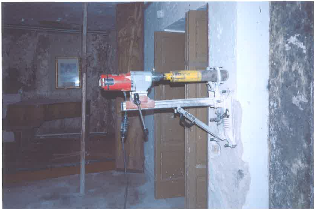
Foto 2. Operazione di carotaggio del pilastro al piano terra del Locale Canonica
