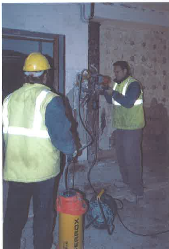
Foto 03. Carotaggio del pilastro a piano terra
