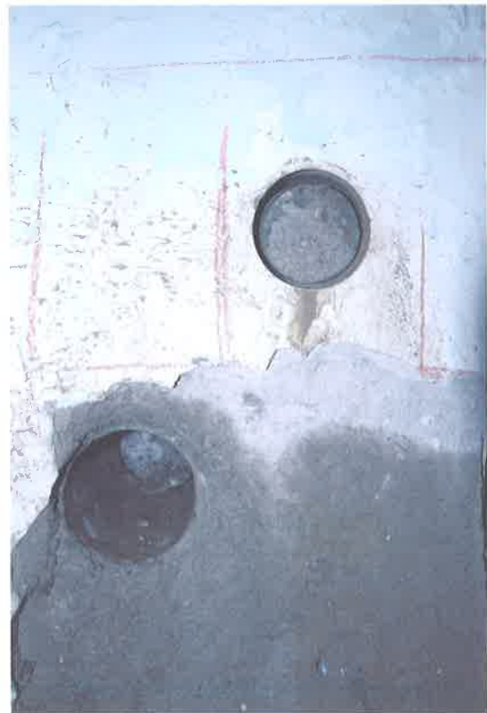
Foto 08. Pilastro a piano terra Locale Canonica
