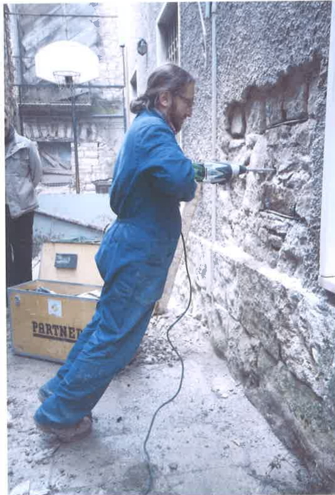
Foto 03. Realizzazione foro per prova endoscopica End_02 su parete esterna Canonica
