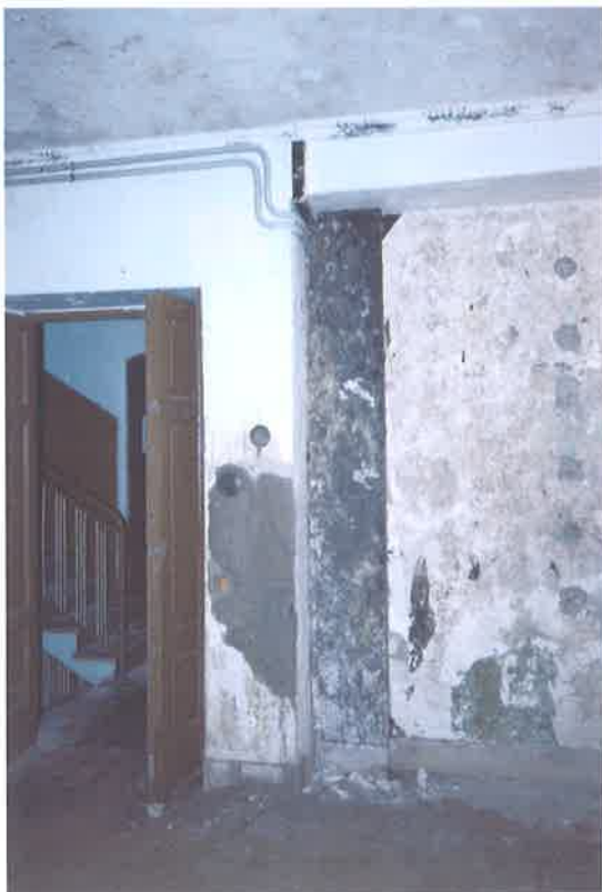
Foto 07. Pilastro a piano terra Locale Canonica
