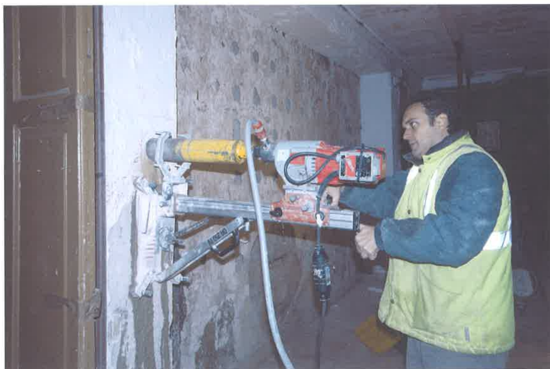
Foto 05. Carotaggio del pilastro piano terra Locale Canonica
