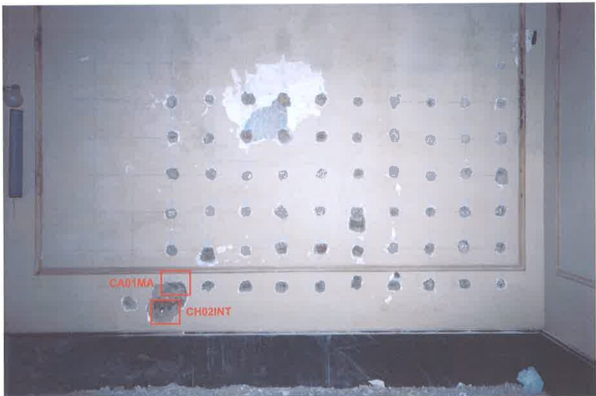
Foto 04. Parete interno chiesa, ubicazione prelievi campioni CA01MA e CA02INT
