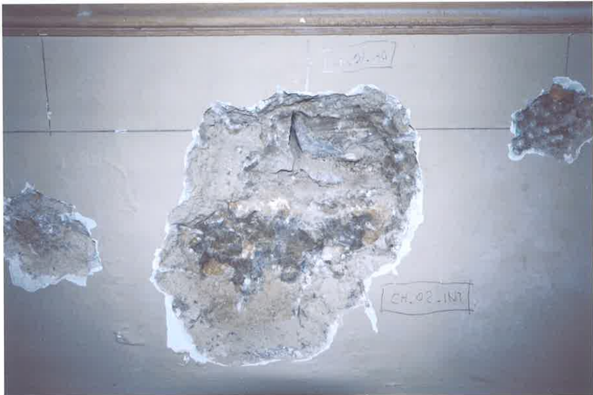
Foto 07. Parete interno chiesa. Prelievo campioni di malta CH01MA e intonaco CH02INT
