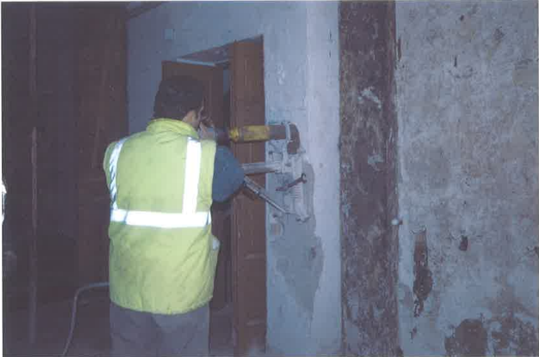
Foto 01. Operazione di carotaggio del pilastro al piano terra del Locale Canonica
