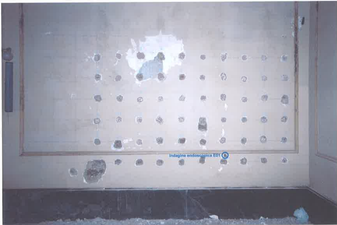
Foto 01. Posizione prova endoscopica End_01 parete interno Chiesa
