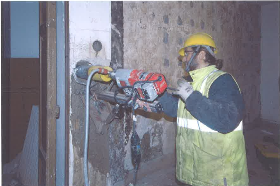
Foto 06. Carotaggio del pilastro piano terra Locale Canonica
