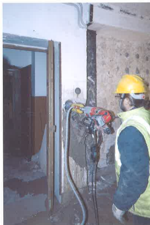
Foto 04. Carotaggio del pilastro a piano terra
