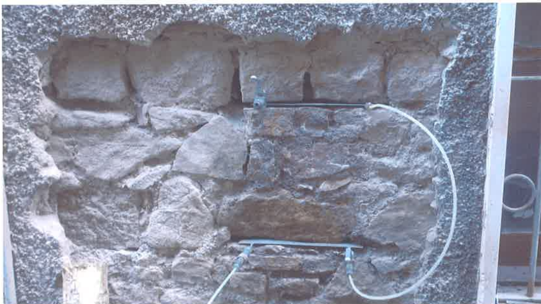
Foto 5 – Prova con martinetto piatto MD2 – Esterno. Posizionamento martinetti
