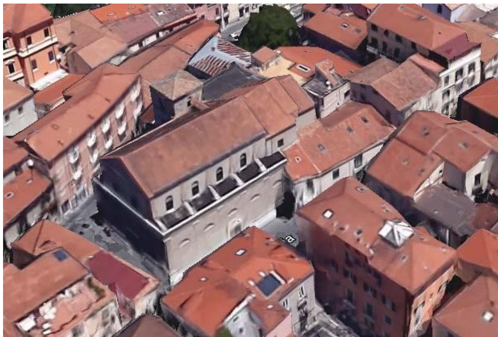
Figura 2 - Vista aerea della struttura
