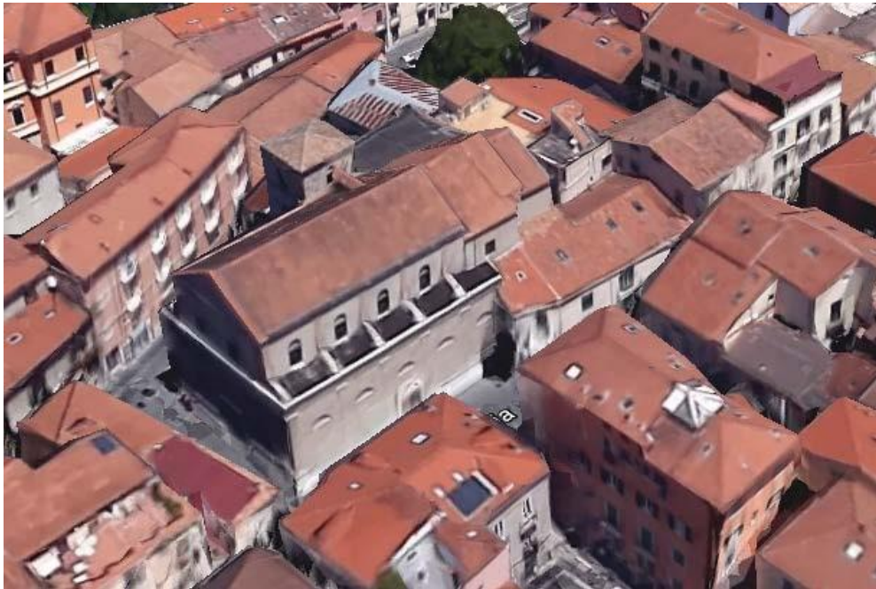
Figura 2 - Vista aerea della struttura
