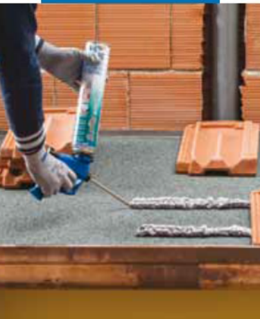
Incollaggio a cordoli di tegole
